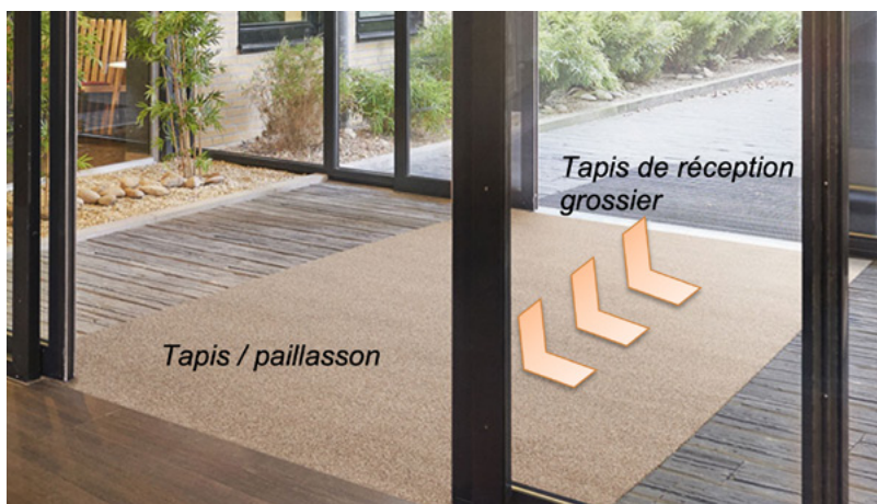
Fig. 16 : Sas de propreté (source Stilmat Suisse)
