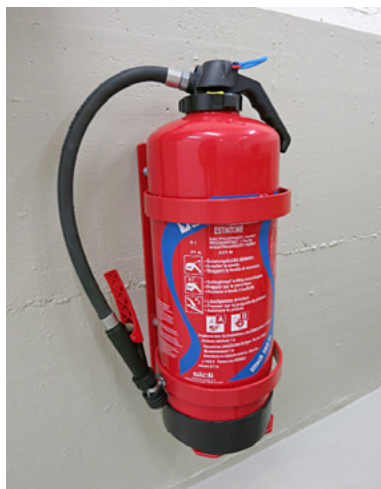
Fig. 13 : Fixation murale résistant aux chocs
