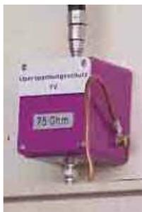
L'alimentation du câble TV dans un ouvrage de protection est couplée sur la prise de parasurtension 75  $\Omega$ , sinon le câble agit comme une énorme antenne et annule les mesures de protection EMP.
