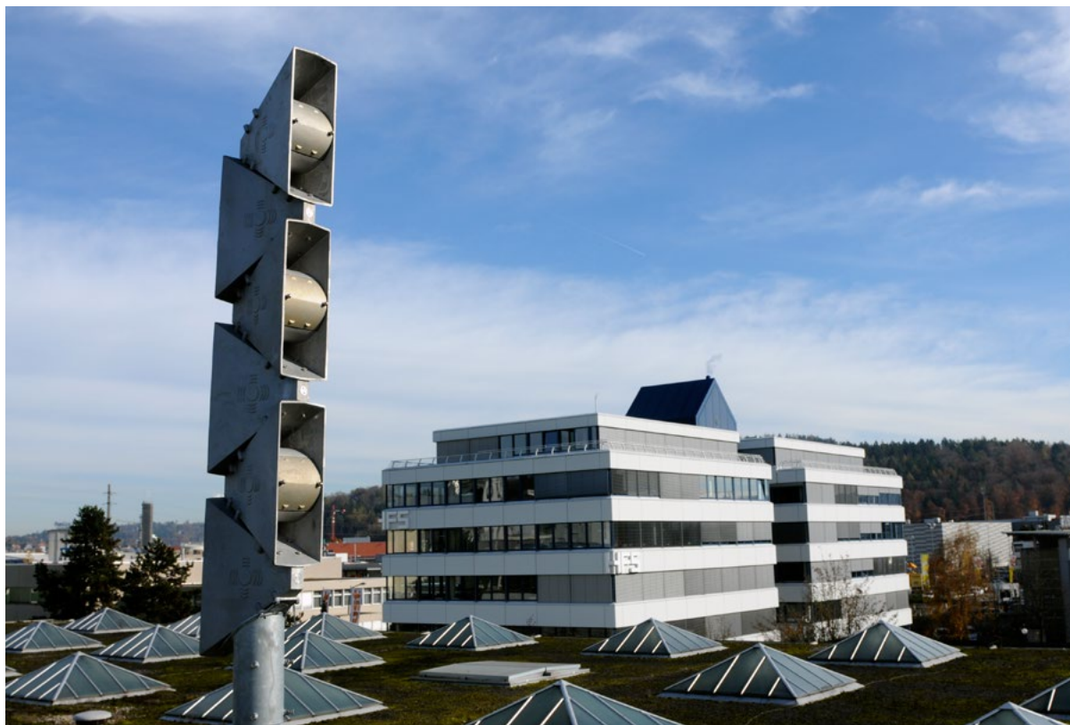
Partout en Suisse, les sirènes fixes peuvent désormais être déclenchées par le système d'alarme POLYALERT.
