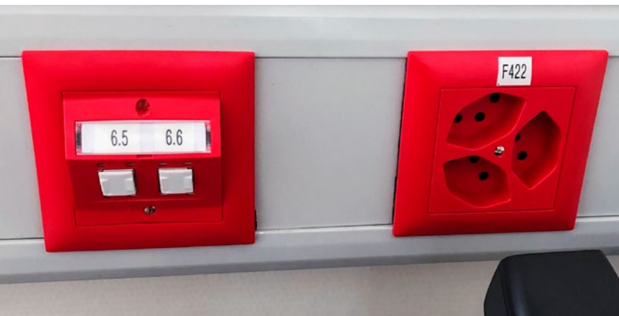
Chaque maison communale a été munie de connexions d'alimentation de secours de couleur rouge destinées aux terminaux indispensables (ordinateur portable, imprimante, téléphone, lampes).
