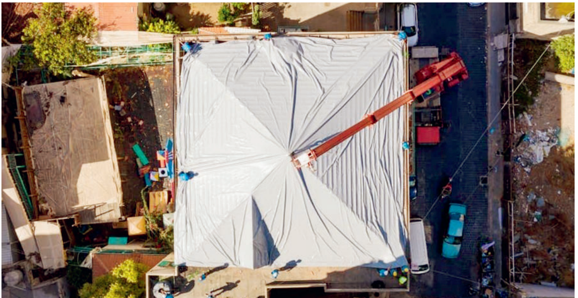
3 Installation d'une bâche dans le quartier de Rmeil, Beyrouth. © LiveLoveBeirut
