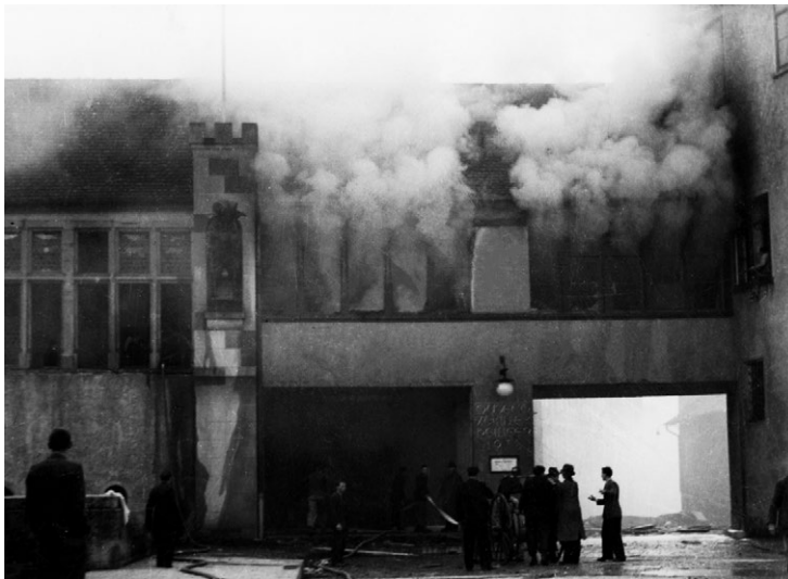
5 Bombenangriff auf Schaffhausen am 1. April 1944. Schäden an Gebäuden im Schönmaiegässchen 1 und in der Klosterstrasse. © Stadtarchiv Schaffhausen (Sig. J 02.25.27_03 und J 02.25.11_10)
