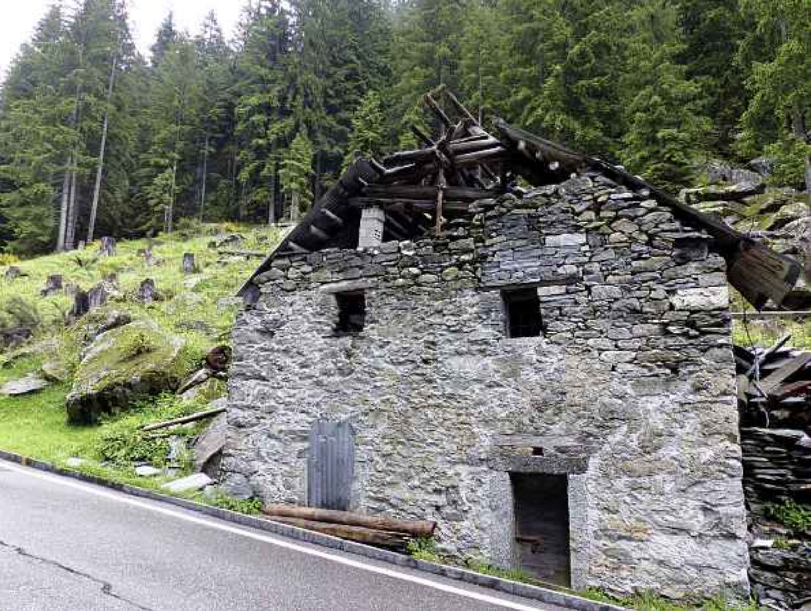
3 L'exemple du Val Bavona/TI montre les conséquences des dangers gravitationnels qui existent depuis des siècles dans les régions alpines. Les chutes de pierres, les éboulements et les glissements de terrain seront toutefois plus fréquents et plus violents avec le changement climatique. Photo H. Schüpbach © Section PBC, OFPP.
