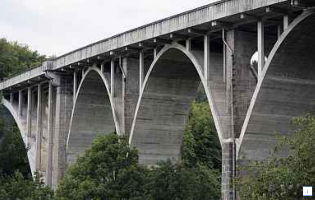
1 Zwei Generationen von Bauwerken: 2 Die Halenbrücke von 1912/1913 (Abb. 1) ist eine der ältesten und elegantesten Eisenbetonbrücken der Schweiz. Die Neubrügg (Abb. 2, erbaut 1535) ist die älteste Holzbrücke im Kanton. Beide Übergänge verbinden jeweils die zwei Gemeinden Bern und Kirchlindach – in der KGS-Datenbank existieren deshalb 4 Datensätze dazu (je zwei pro Gemeinde). Fotos: Samuel Bauhofer, © Fachbereich KGS, BABS.
