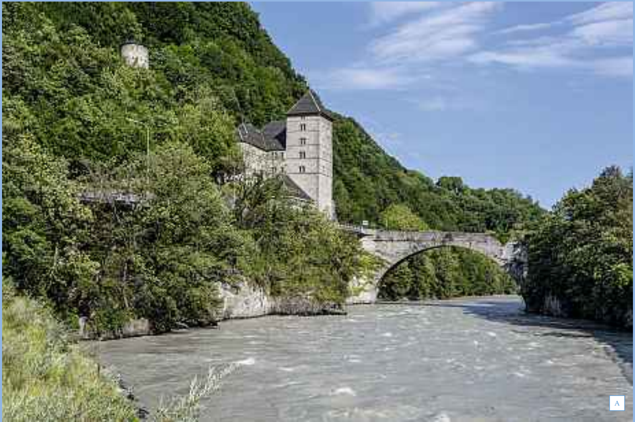
A: Le château de Saint-Maurice (VS) est classé comme bien culturel d'importance nationale (objet A) dans l'Inventaire PBC. Le pont, qui relie les cantons du Valais et de Vaud, est aussi un objet A. Photo: © Roland Zumbühl, Arlesheim, www.picswiss.ch
